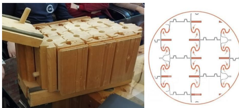
Рис. 1. Макет стеновой конструкции. Соединение шип-паз [1]
