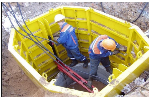
Рис. 2. Монтаж съемной опалубки для работ в котловане
